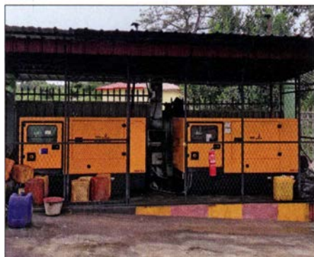
36-kW-Generatoren des Hotels auf Bioko
